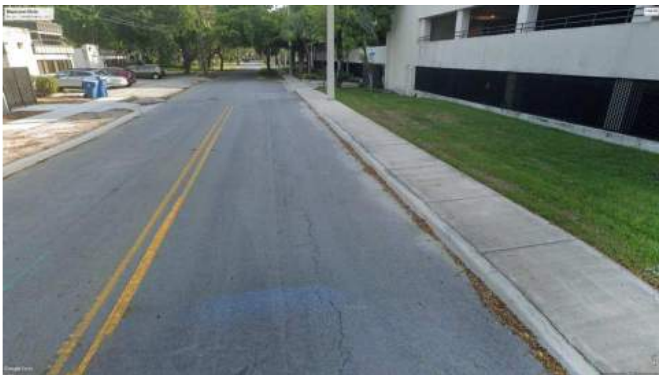
Ruas e Avenidas restauradas, pavimentadas e sinalizadas.
