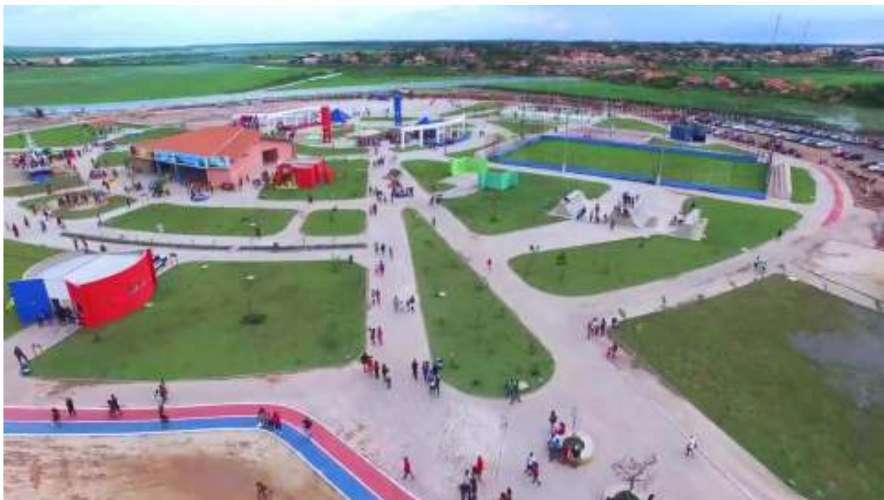
Restauração, melhoramento e ampliação do APA
